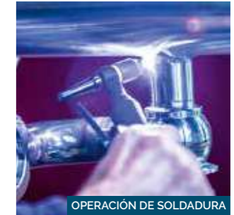
OPERACIÓN DE SOLDADURA
