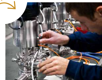
MONTAJE DE LAS VÁLVULAS PROCESO
