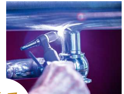
SOLDADURA ORBITAL DE UNA ESTACIÓN DE RASPADO
