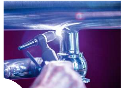
SOLDADURA ORBITAL DE UNA ESTACIÓN DE RASPADO
