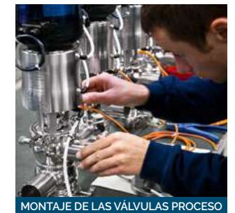
MONTAJE DE LAS VÁLVULAS PROCESO
