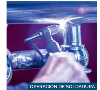
OPERACIÓN DE SOLDADURA
